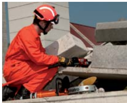
Отличная комбинация: разлом бетона при помощи СС 20 С и перерезание арматуры мини резаком CU 4007 С (или SMC 4006 С).
